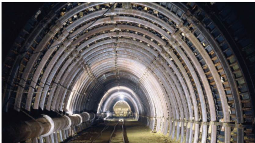
Štola vodárenského souboru Vinice v Plzni / Tunnel of the water management complex Vinice in Pilsen
